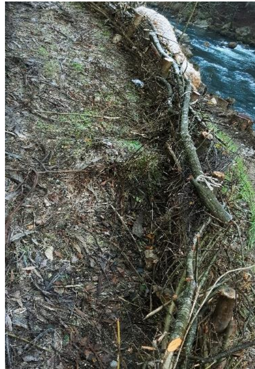
Figura 15 - Técnicas de modelação / reperfilamento das margens (paliçada) no Laboratório Rios+ de Valongo | 06.01.2021 | Fonte: Autor
