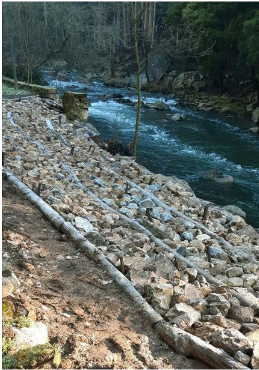
Figura 17 - Técnicas de modelação / reperfilamento das margens (enrocamento vivo) no Laboratório Rios+ de Valongo | 06.01.2021 | Fonte: Autor
