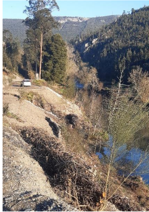
Figura 16 - Técnicas de modelação / reperfilamento das margens (faxinas, entrançado, paliçada, muro vivo e grade viva), e de reabilitação da galeria ripícola (estacaria viva) no Laboratório Rios+ de Gondomar | 12.01.2021 | Fonte: Autor
