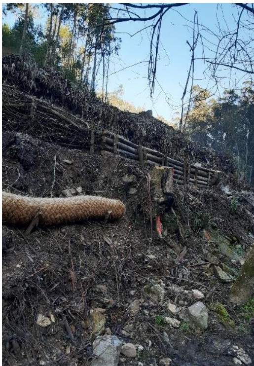
Figura 14 - Técnicas de modelação/reperfilamento das margens (faxinas, entrançado e biorrolo) no Laboratório Rios+ de Valongo | 06.01.2021 |
