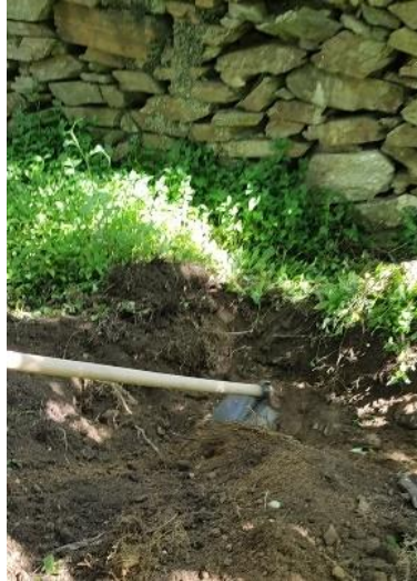
Figura 56: Abertura de uma cavidade no solo para permitir a colocação da madeira. Fotografia de autoria própria.
