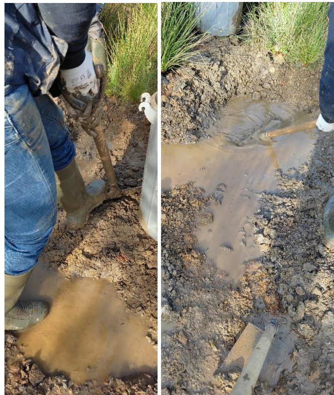
Figura 38: Escavação dos charcos, utilizando pás e enxadas. Fotografias de autoria própria.
