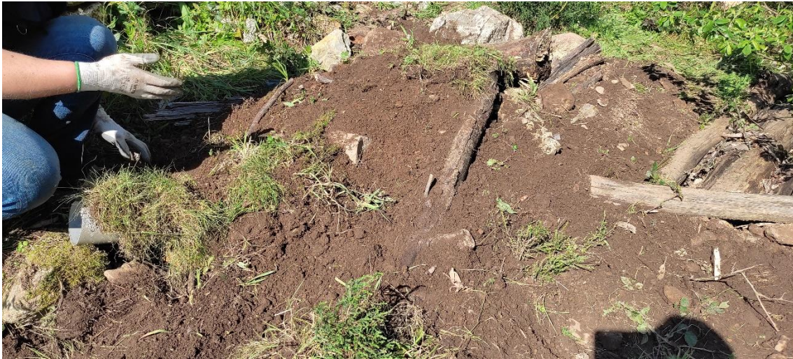
Figura 52: Colocação da camada superficial retirada no início, tendo o cuidado de cobrir os tubos. Fotografia de autoria própria.
