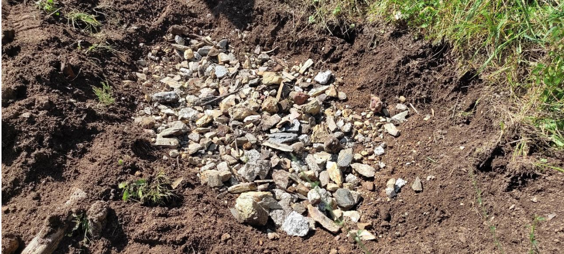
Figura 48: Camada inicial de pequenas pedras para auxiliar o solo na drenagem de água. Fotografia de autoria própria.
