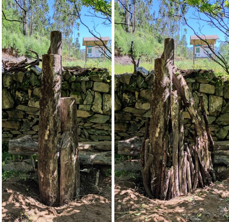
Figura 58: À esquerda, colocação na vertical dos troncos de maiores dimensões e à direita de menores dimensões. Fotografias de autoria própria.
